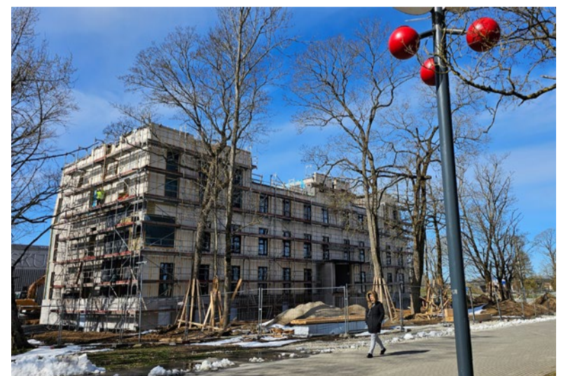
В Юрьев день в строящемся отеле прошли как праздник строипил, так и церемония закладки краеугольного камня. Фото: КАЛЛЕ ПЯРТ
