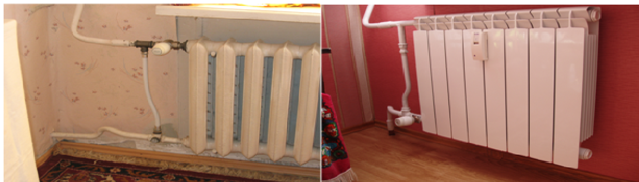
Joonis 6.15 Eestis renoveeritud 1-torusüsteemid. 20
