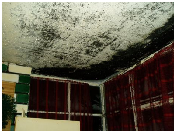
Joonis 5.15 Kinniehitatud rõdu, kuhu juhatakse köögi akna kaudu niiske õhk.
