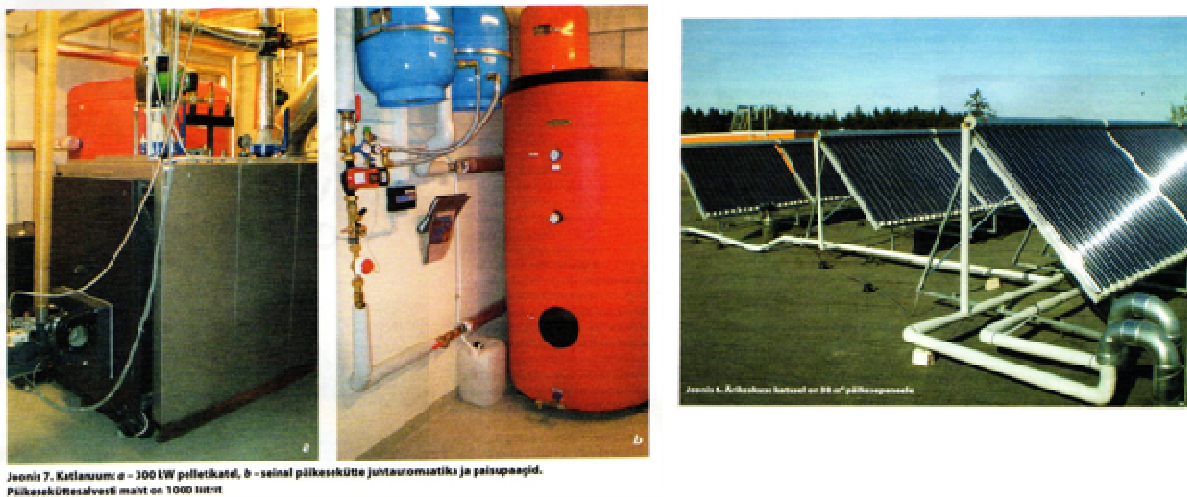
Joonis 8.4 Kohila ärikeskuse soojusvarustuse süsteem. 26
