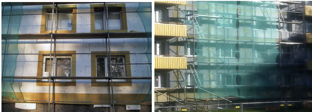
Joonis 5.7 Polüstereenplaatide paigaldamise viisid.
