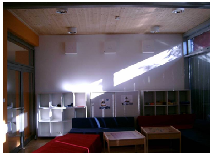
Joonis 7.10 Seina(le) paigaldatava lokaalse sund sissepuhke-väljatõmbe süsteemi välis- ja seestvaade.
