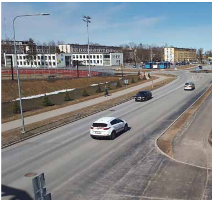
Puru tee läbimurre 2017 vs. 2022. Foto: Kalle Pärt
